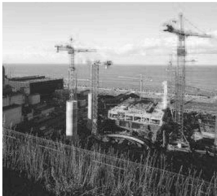
Chantier du réacteur nucléaire à Flamanville (Manche). Après l'annonce de la construction d'un deuxième EPR, le lancement d'une troisième centrale est sérieusement envisagé. Bassignac/Le Figaro
