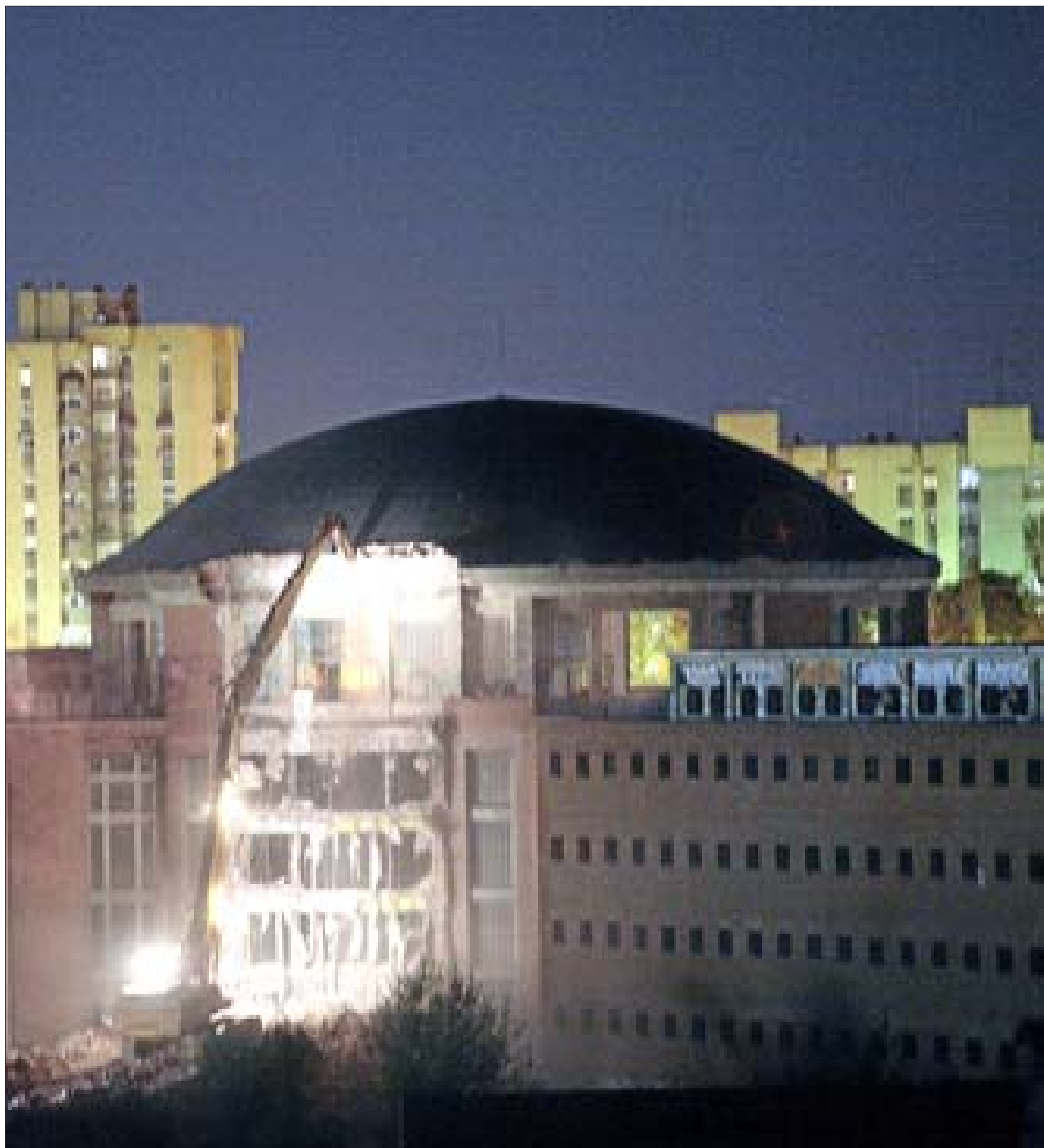
La pala mecánica demoliendo anoche la bóveda central de la prisión de Carabanchel. / ÓSCAR MONZÓN
