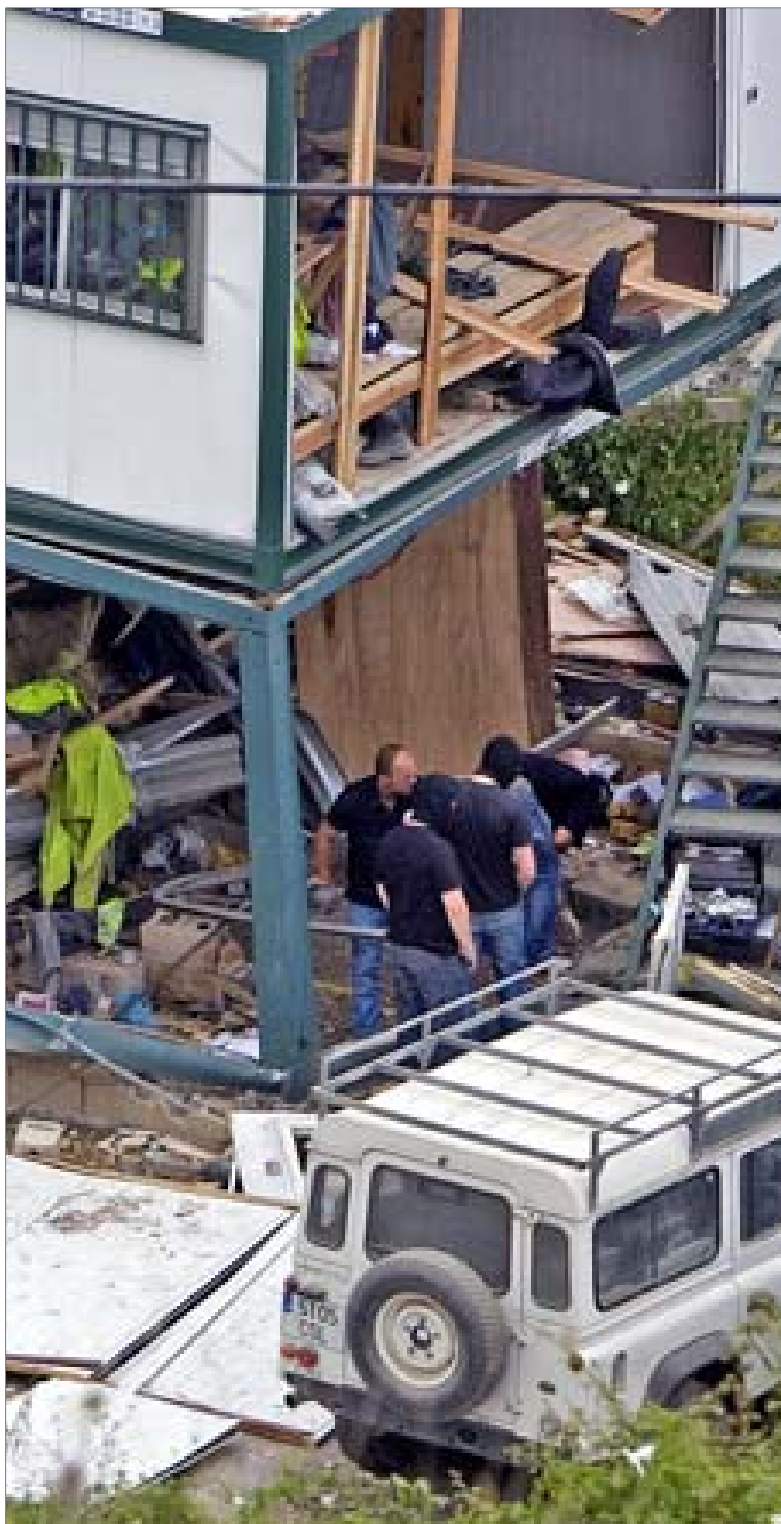
Imagen de los daños causados por ETA, ayer en Orio. / JUSTY GARCÍA KOCH
