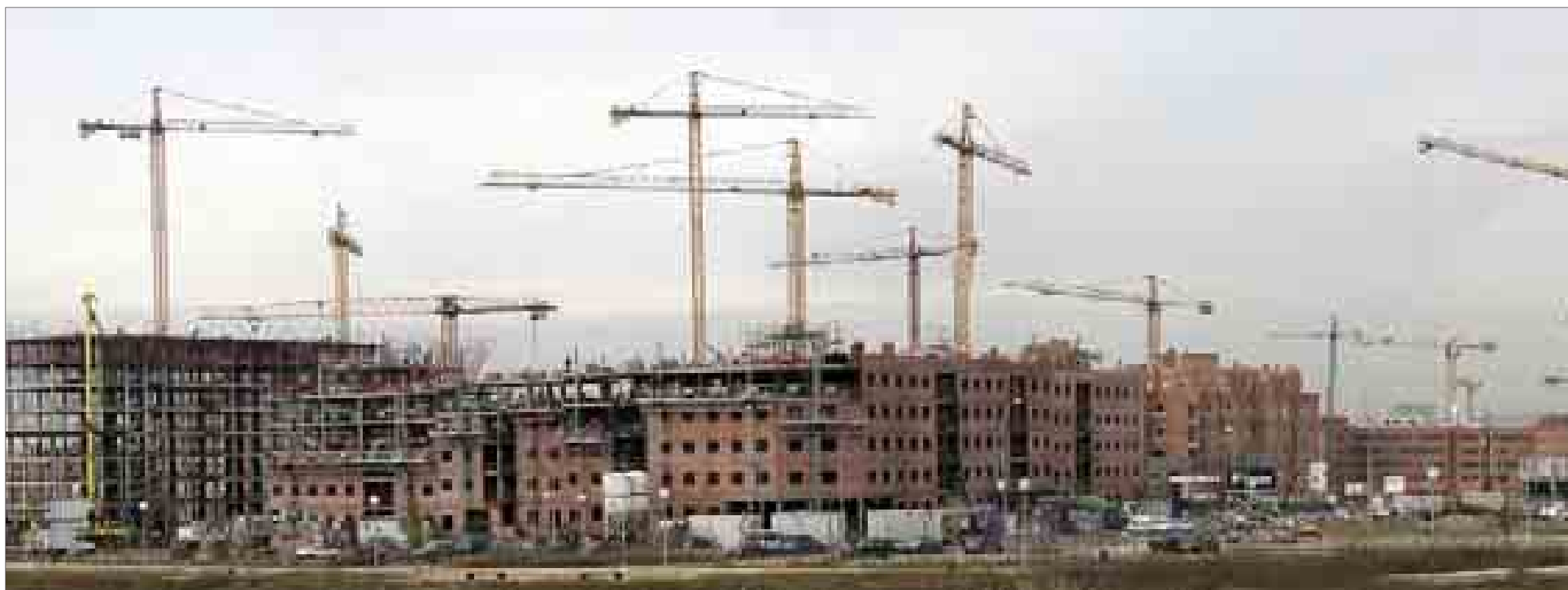
Construcción de una promoción de pisos en el PAU de Vallecas, zona por donde se está produciendo el crecimiento de la capital. /ANTONIO M. XOUBANOVA
