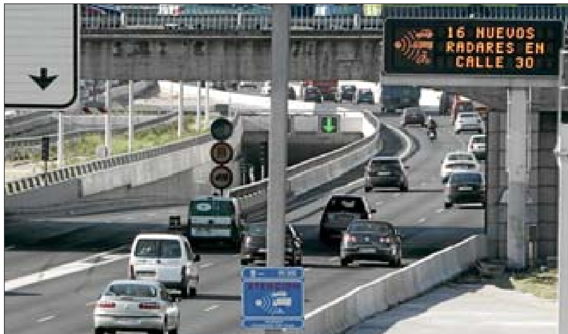
Entrada de uno de los túneles de la M-30, ayer, donde se avisa de la ubicación de los radares. / JAVIER LIZÓN-EFE
