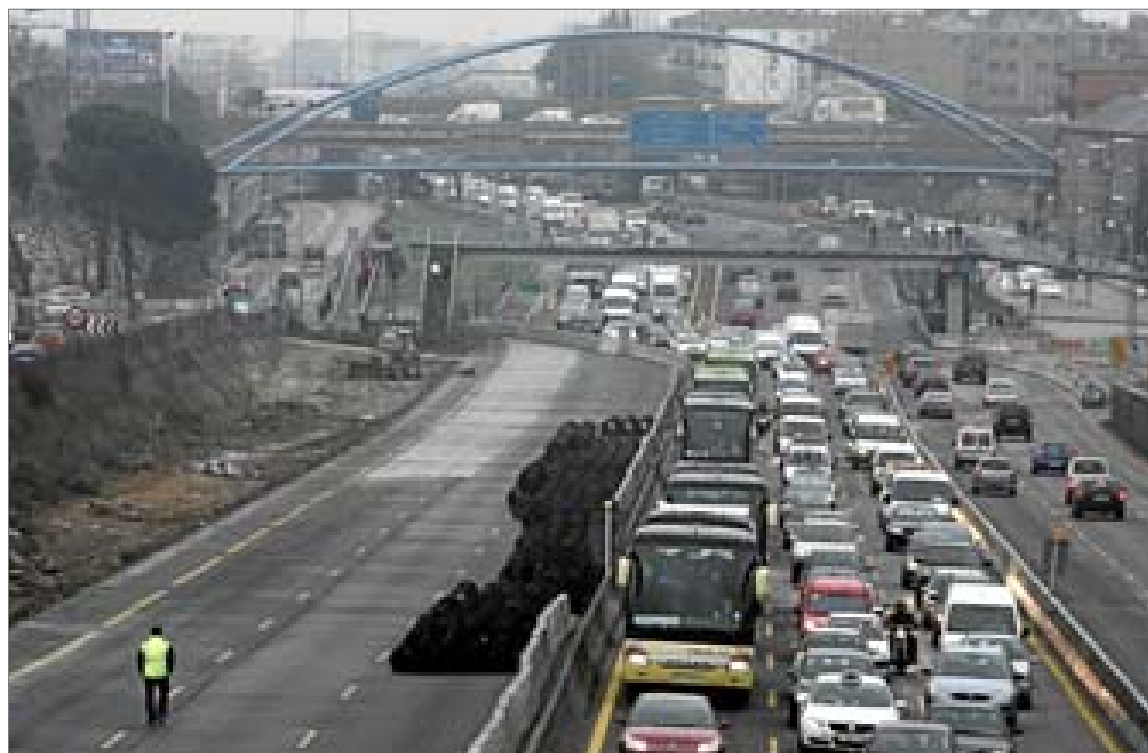
Hace días se producen desvíos en la A-2, a la altura de la calle Alcalá, para iniciar las obras de la rotonda. / J. VILLANUEVA
