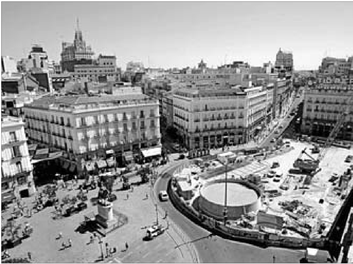
Obras de la estación de Cercanías de la Puerta del Sol. / ANTONIO M. XOUBANOVA
