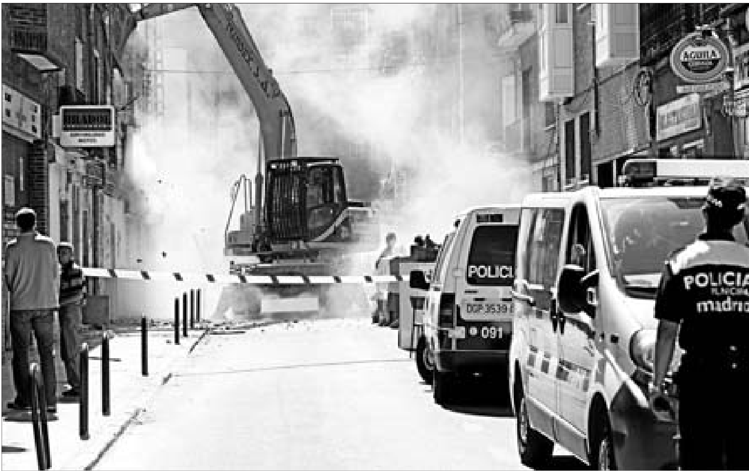
Momento en el que el inmueble de la calle de Algodonales, número 8 era demolido, ayer. / ANTONIO M. XOUBANOVA / CARLOS BARAJAS
