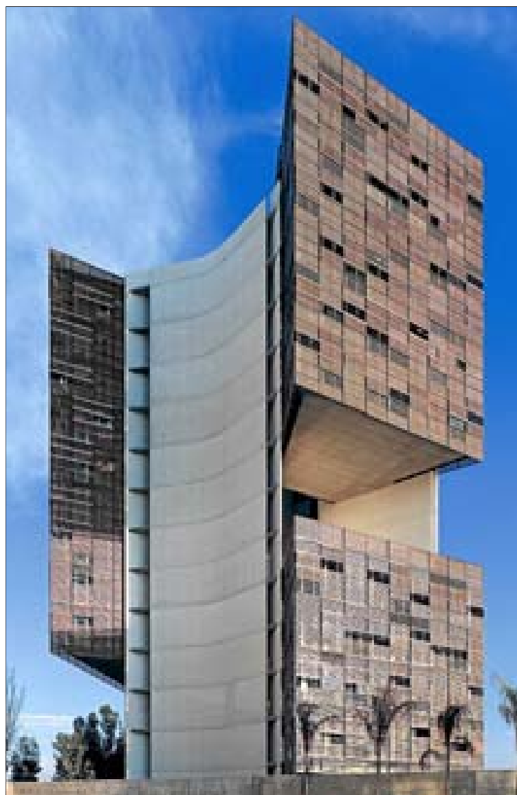
La torre Cube de Guadalajara (México), proyecto de Carme Pinós. / DUCCIO MALAGAMBA
