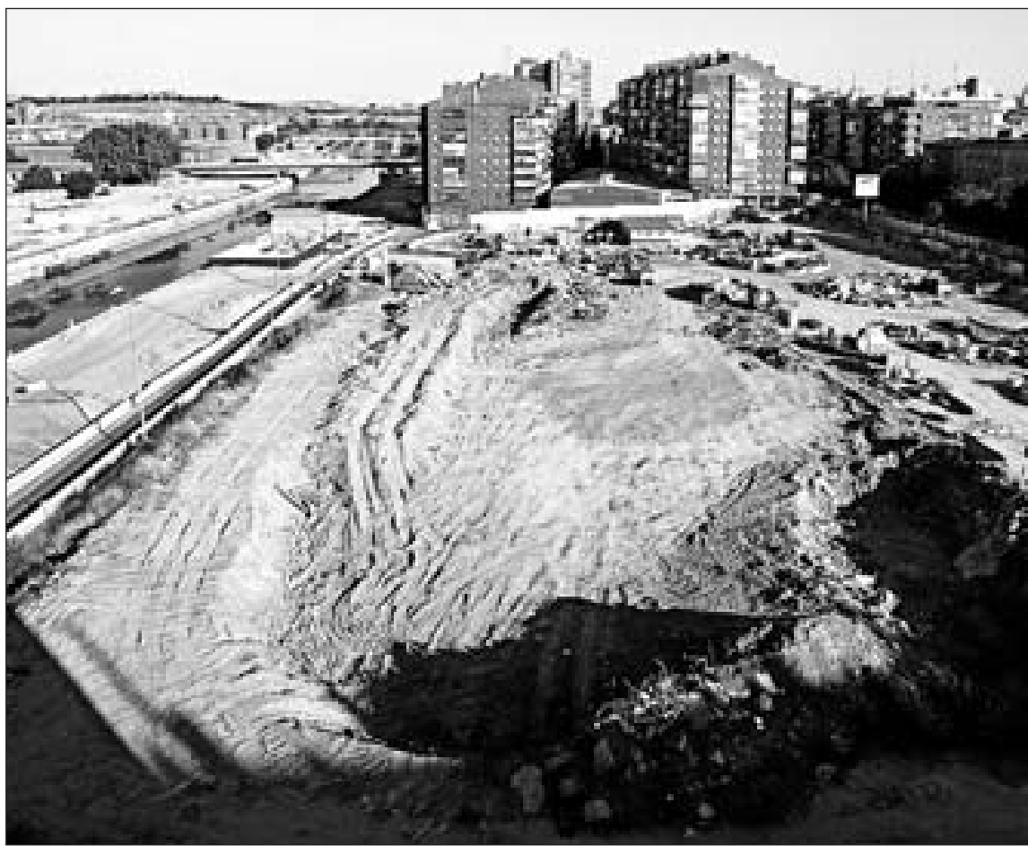
La parcela de la inmobiliaria Nozar es utilizada por el Ayuntamiento para depositar los escombros de la M-30. / JAVI MARTÍNEZ
