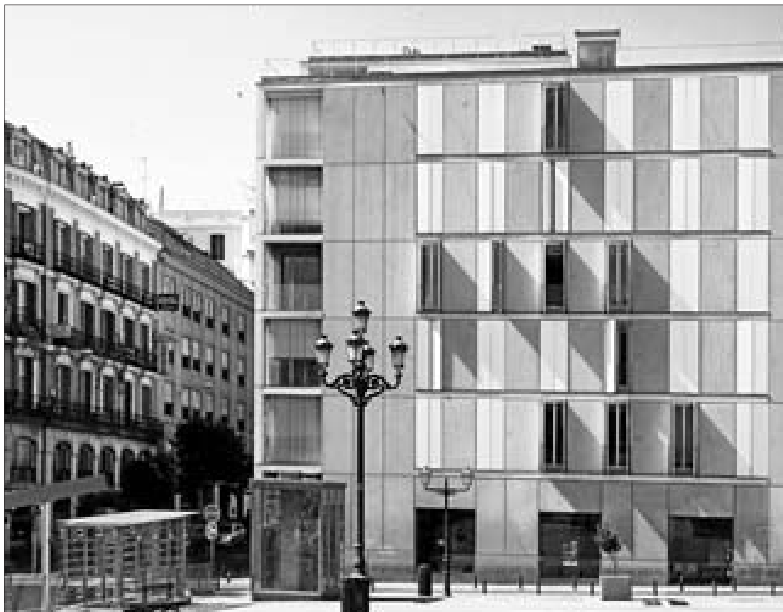
Vista lateral de las 22 viviendas construidas por Carlos de Riaño Lozano en la calle Clavel. / EL MUNDO
