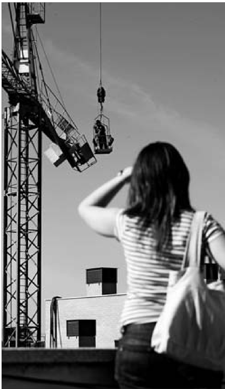
Dos operarios fijan los contrapesos en la contraflecha de la grúa averiada en Tetuán. / ANTONIO HEREDIA
