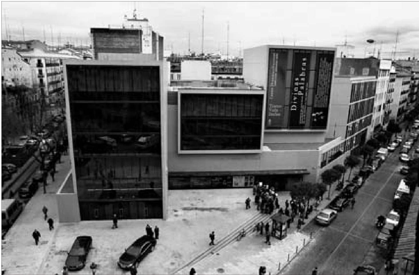
Los tres módulos de hormigón, acero y cristal que componen, entre las calles Argumosa (derecha) y Valencia, el nuevo Teatro Valle-Inclán de Madrid, ayer. / DIEGO SINOVA
