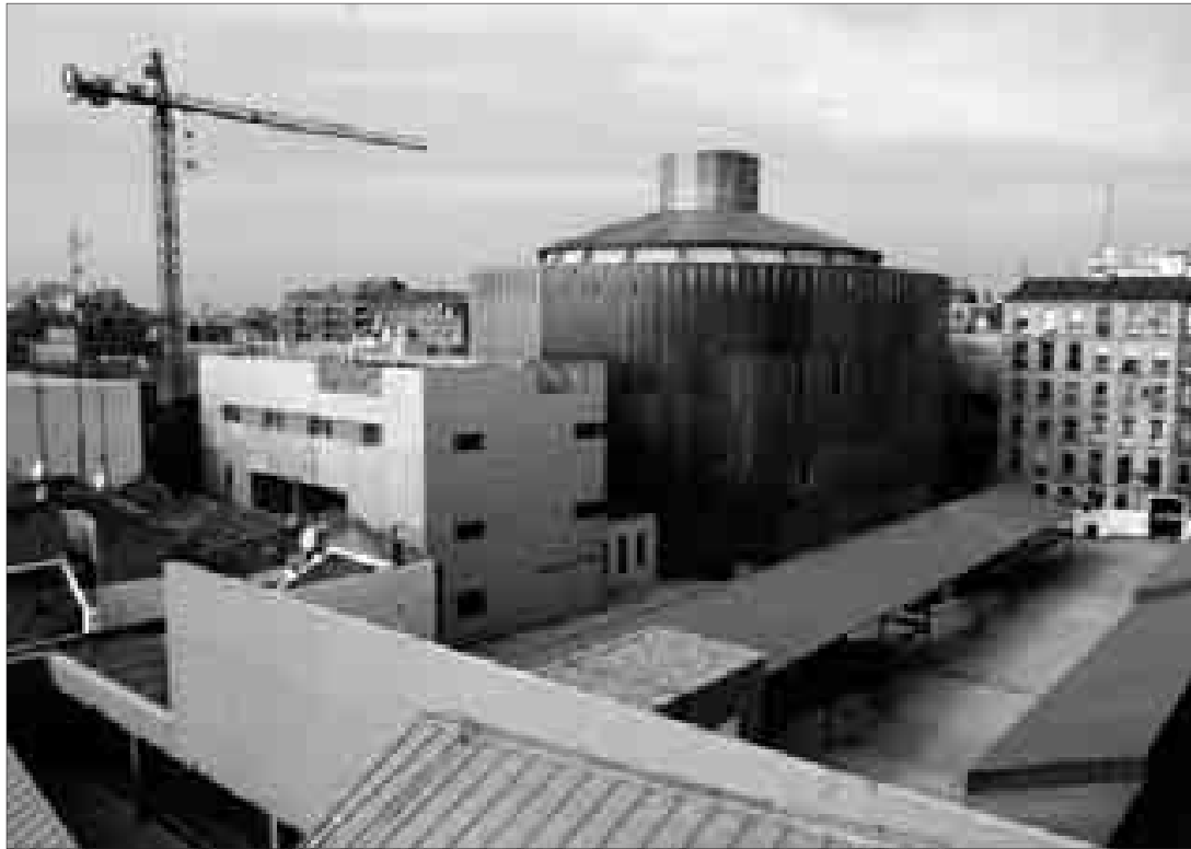
Imagen del exterior del edificio que acogerá el Circo Estable en Madrid, situado en la ronda de Atocha. / DIEGO SINOVA
