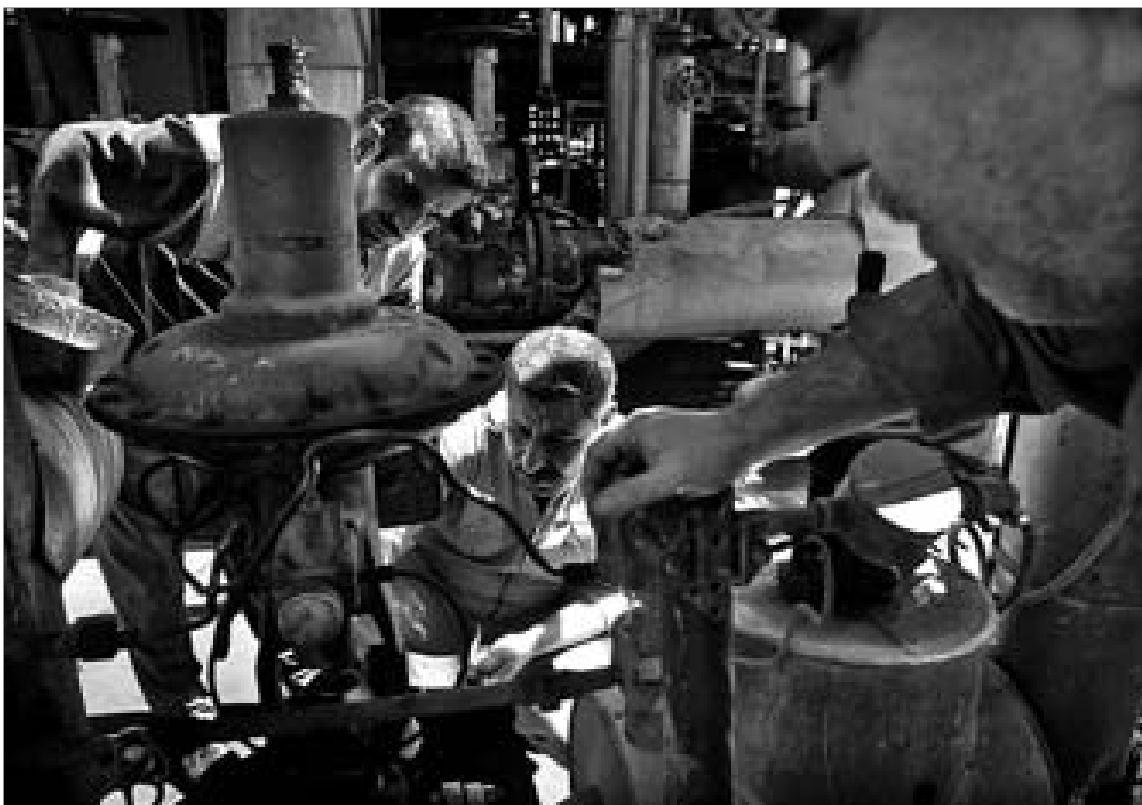
Mecánicos iraquíes intentan arreglar una válvula en la refinería de Al Dura, a las afueras de Bagdad. / REUTERS
