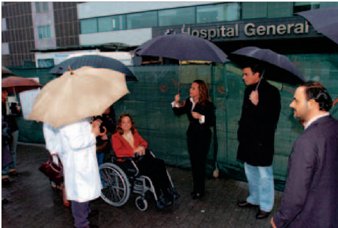
Los ediles del PSOE Carmen Sánchez-Carazo, Trinidad Jiménez y Pedro Sánchez, ayer, en una entrada de La Paz en obras. / C. MIRALLES
