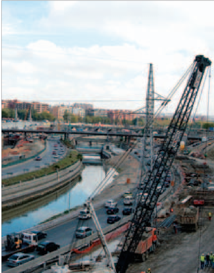
Obras de reforma de la M-30 junto al río Manzanares. PACO TOLEDO
