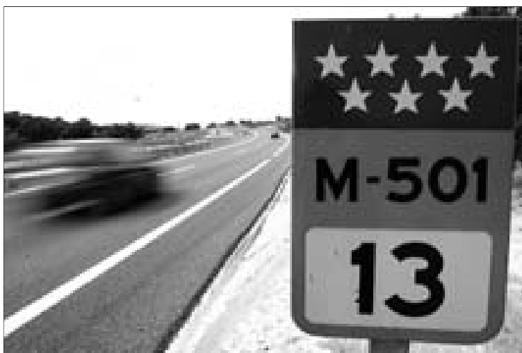
Imagen de uno de los kilómetros de la M-501 convertidos en autovía. / CARLOS BARAJAS
