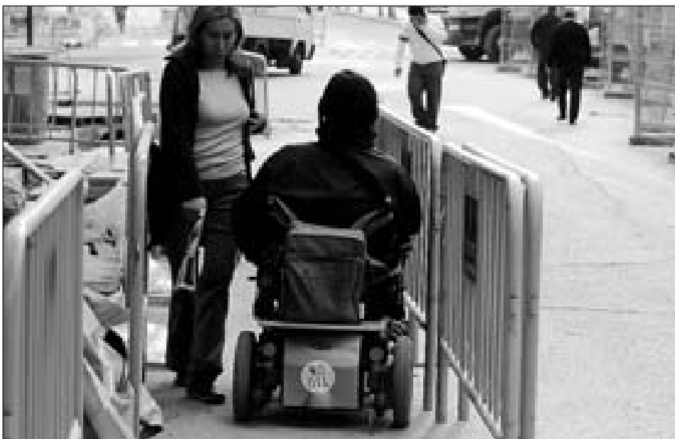
CAMINANDO ENTRE OBRAS. Las zanjas han complicado más el difícil camino de los discapacitados. El estrechamiento de las aceras o el asfalto roto suponen nuevos obstáculos.
