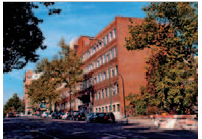
Fachada del CSIC en la calle de Velázquez. / CARLOS MIRALLES
