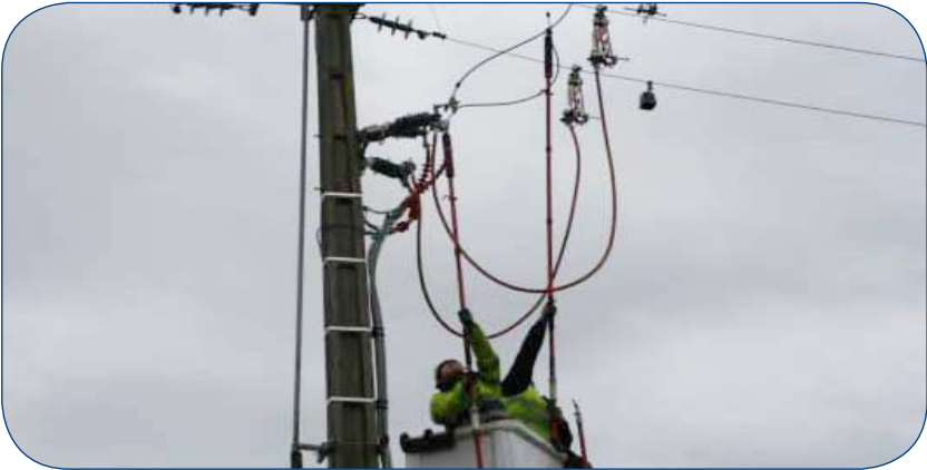
Travaux sous tension de 20kV
