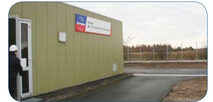
Entrée du bâtiment de protections et centre de distribution dans la sous-station de St. Laurent
