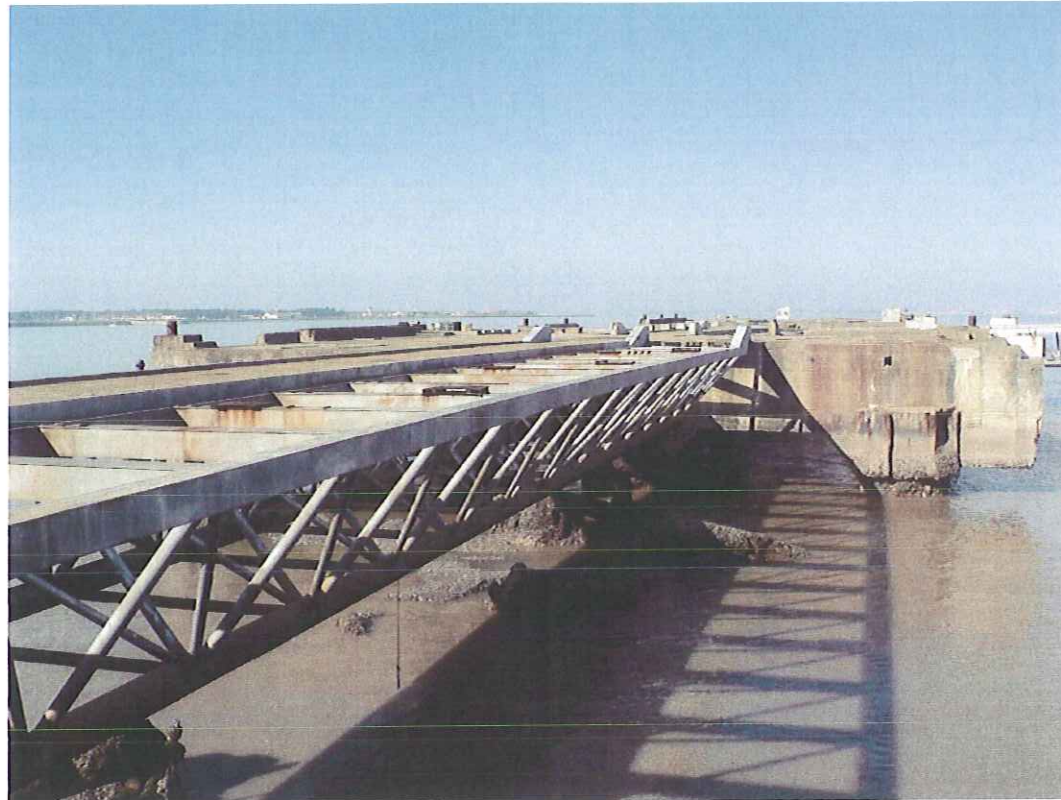
Photo n°8 - Tablier pour le supportage des tuyauteries de l'ancien terminal pétrolier (en regardant vers le nord)
