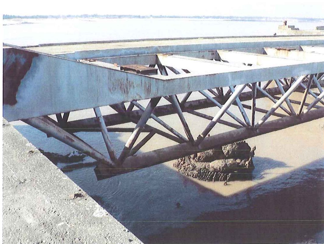
Photo n°9 - Tablier pour le supportage des tuyauteries de l'ancien terminal pétrolier (en regardant vers le nord)
