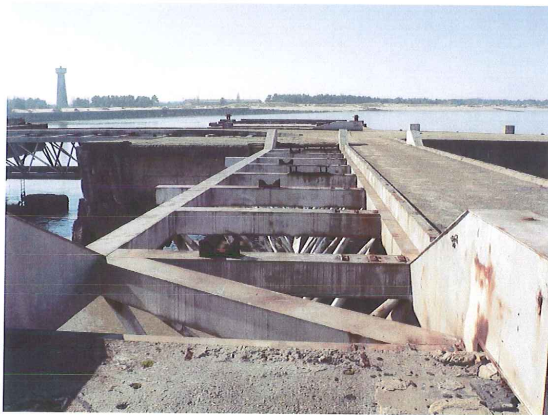
Photo n°20 - Appontement vu depuis le môle et accès (en regardant vers l'ouest)
