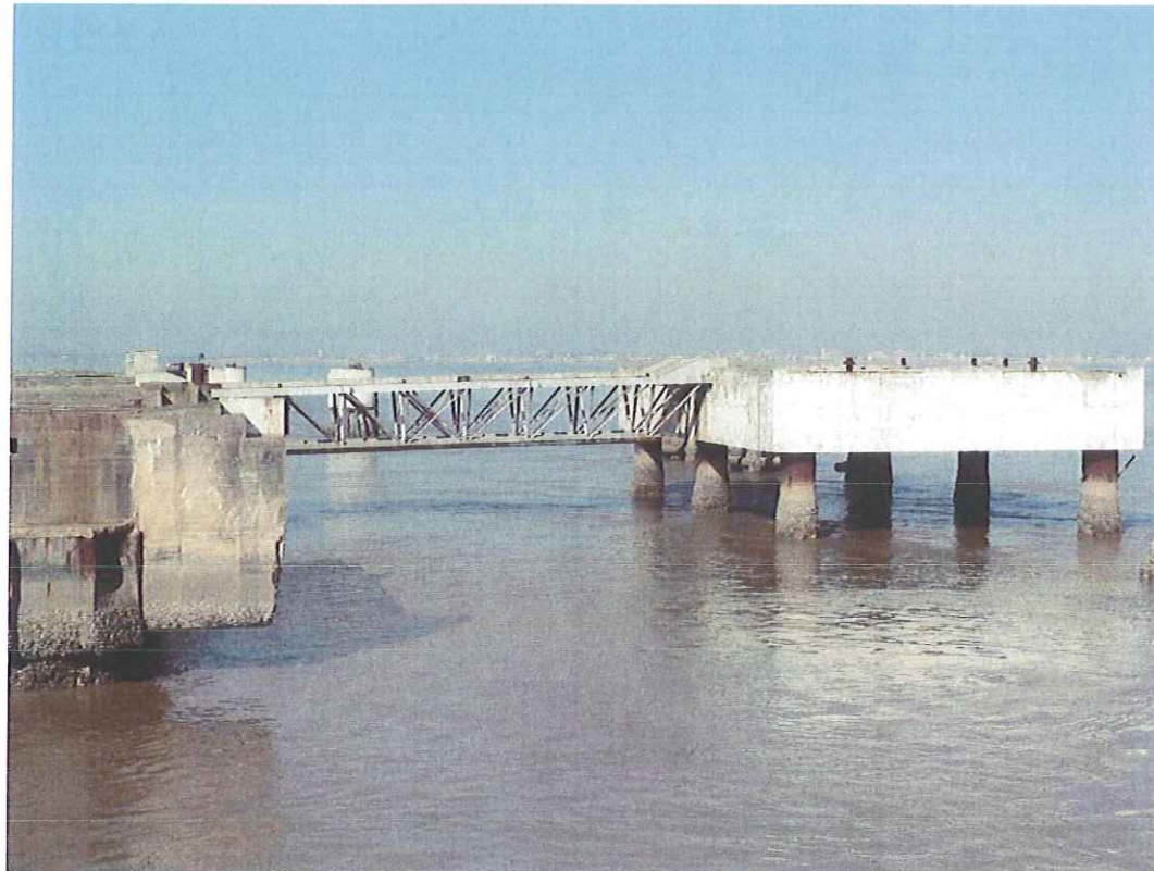
Photo n° 17 - Môle et accès (en regardant vers le nord)
