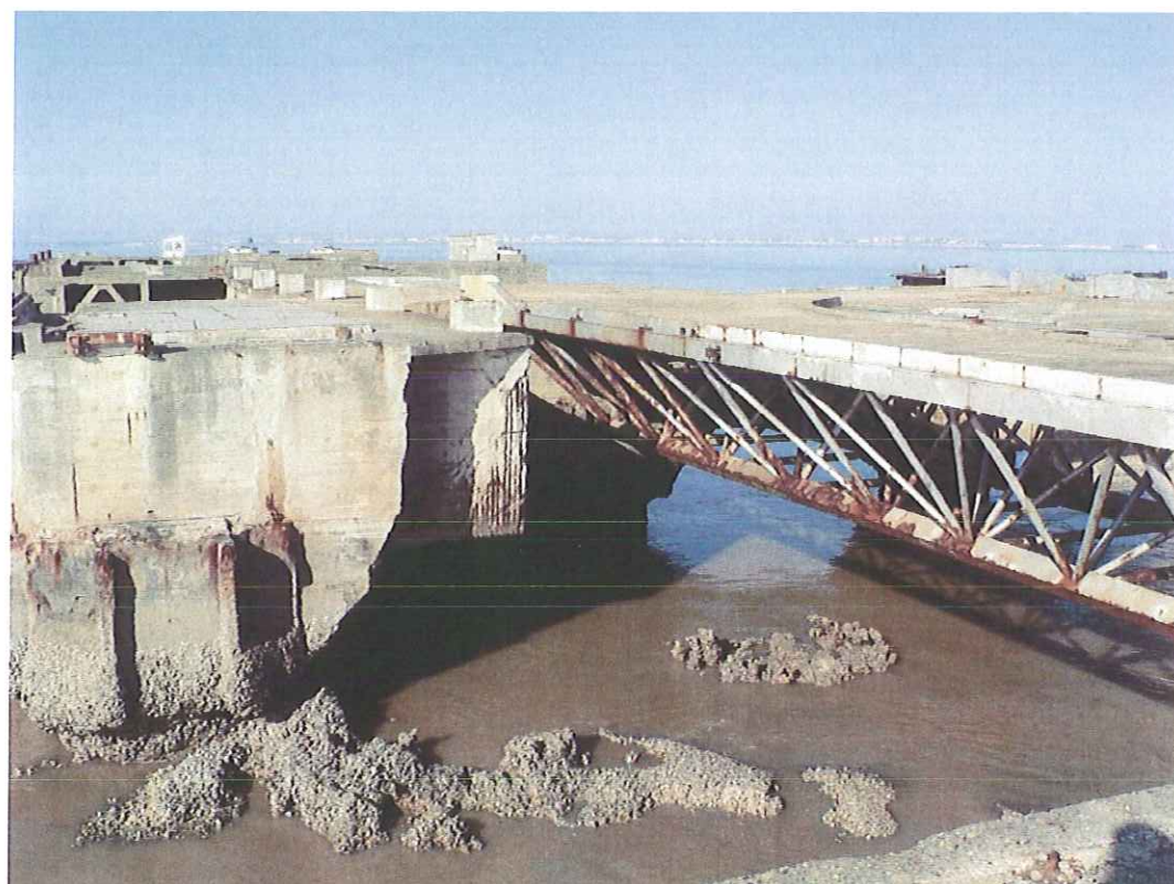
Photo n° 10 - Tablier pour le supportage de la route de l'ancien terminal pétrolier (en regardant vers le nord)
