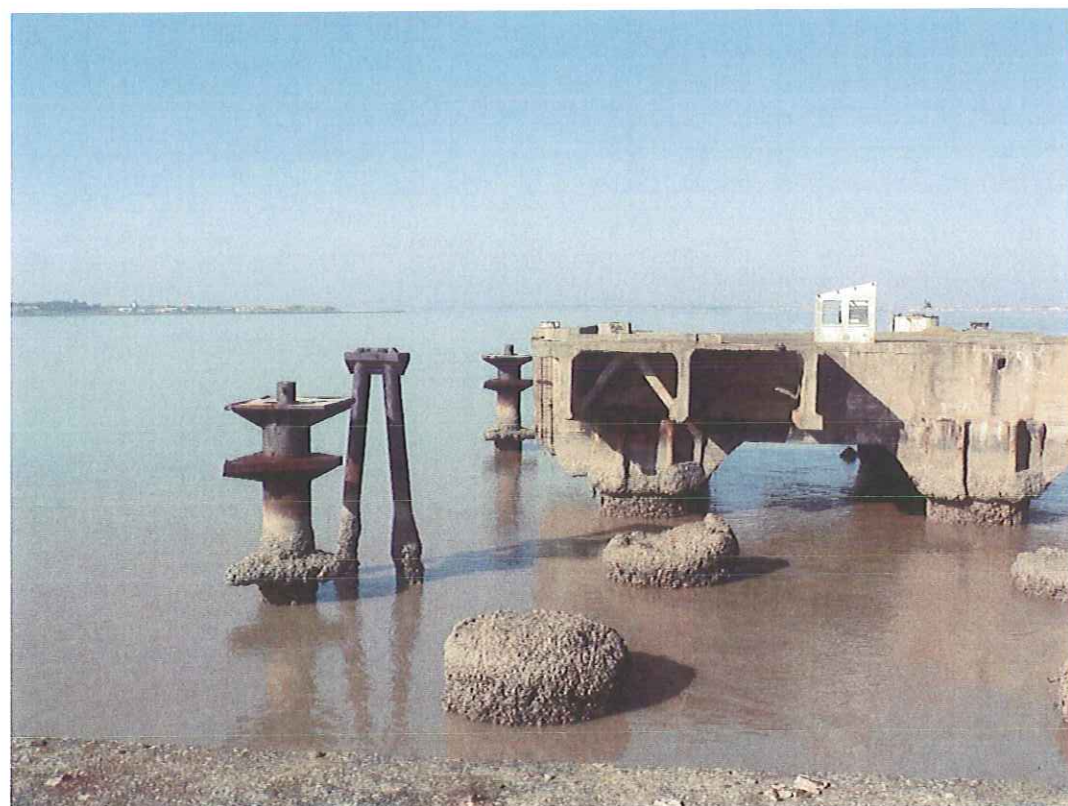
Photo n° 13 - Ancien Tablier à l'extrémité de l'appontement (en regardant vers le nord)
