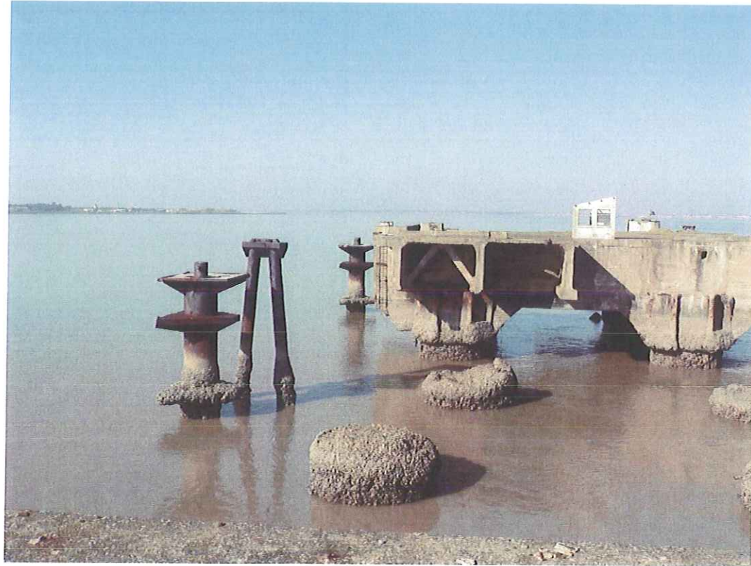
Photo n° 16 - Restes des anciennes fondations (en regardant vers le nord)
