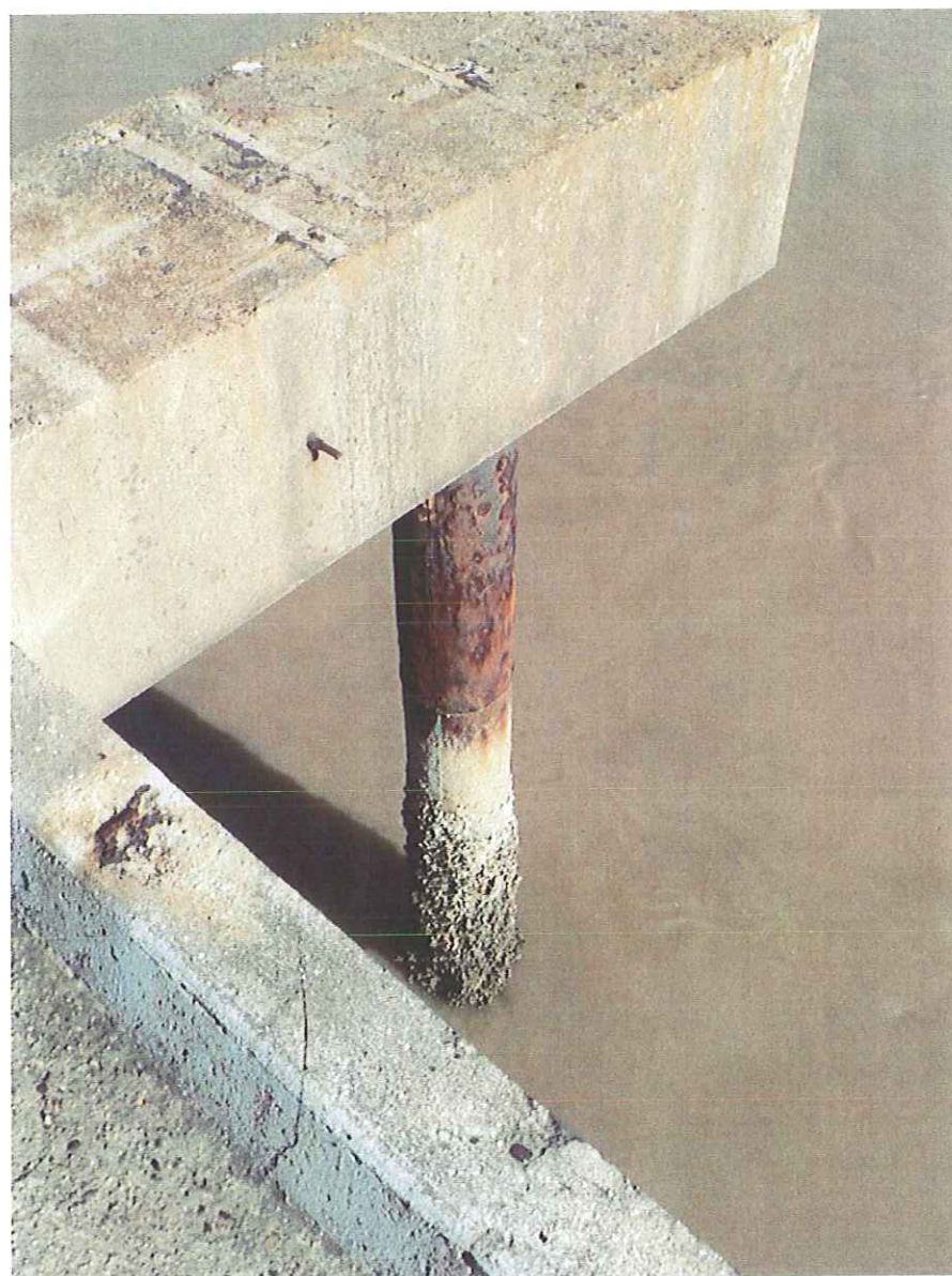
Photo n°4 - Vue d'un chevêtre et d'un pieu de l'estacade
