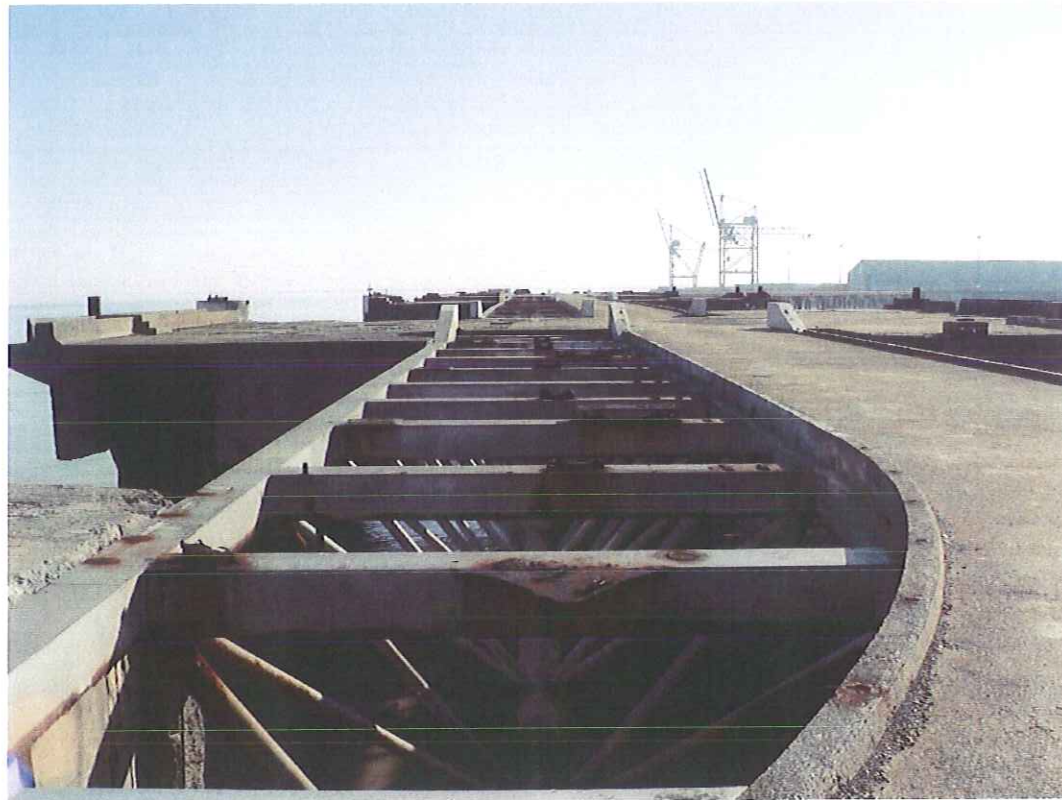
Photo n°11 - Tablier pour le supportage des tuyauterie de l'ancien terminal pétrolier et la route (en regardant vers le sud)
