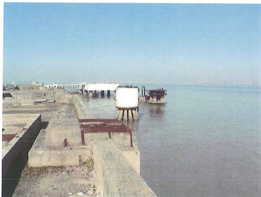
Photo n°21 - Vue sur le môle et des ducs d'Albe
