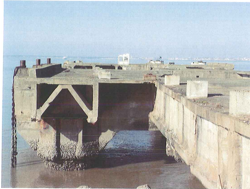
Photo n°14 - Ancien Tablier (en regardant vers le nord)
