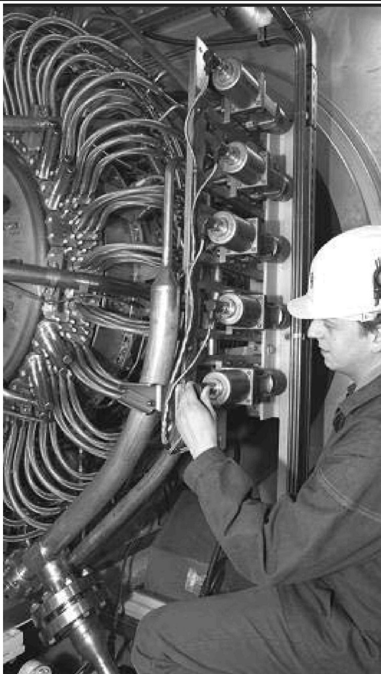
Station de compression de gaz naturel. Fin 2008, la Russie pesait pour 14 % dans les approvisionnements de GDF Suez, derrière la Norvège (23 %) et les Pays-Bas (15 %). Maillac/Réa
