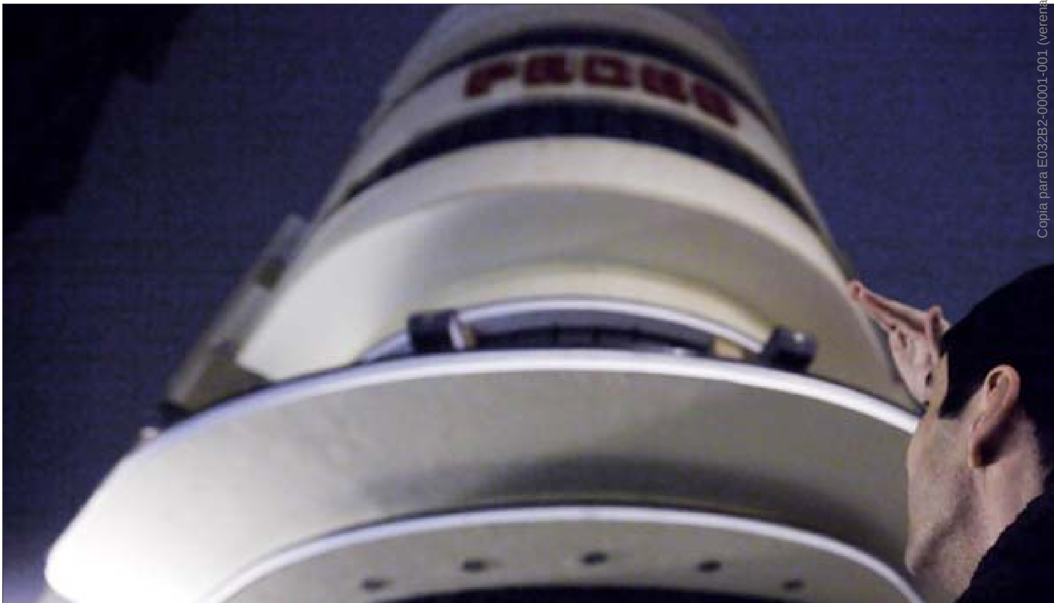
Edificio de la discoteca Pachá, en la calle de Barceló, que fue clausurada y abierta posteriormente por la Concejalía de Medio Ambiente del Ayuntamiento de Madrid. / GONZALO ARROYO
