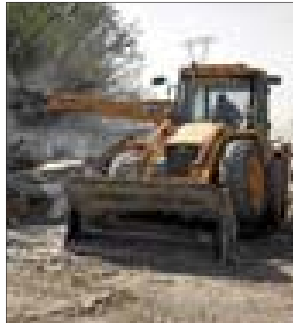
Derribo de una casa. / J. MORÓN
