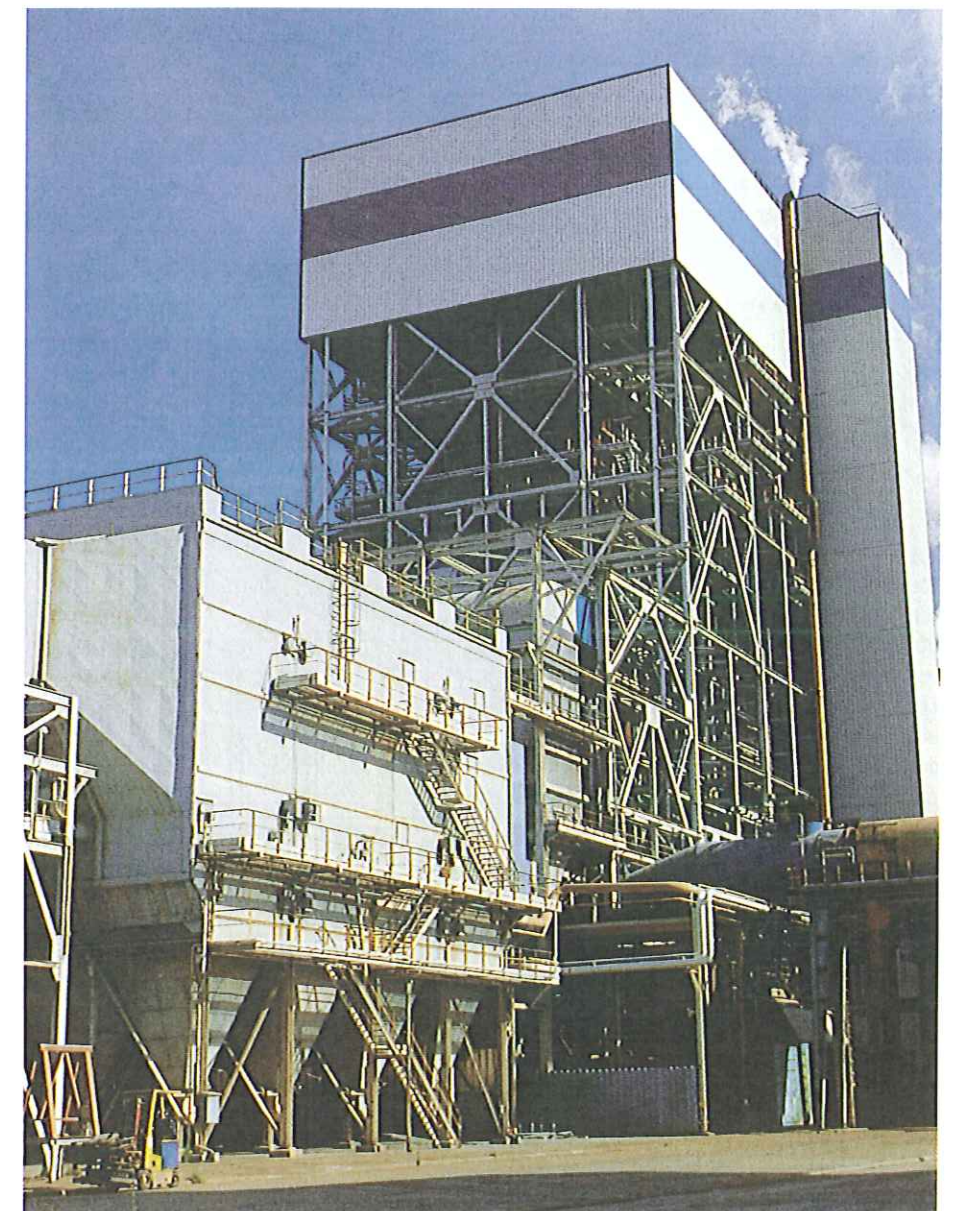
Chaudière Groupe V.
