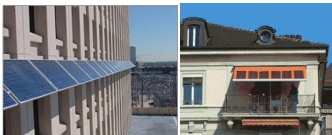
Figuras 6.5: Paneles solares en lugares de sombreado: ventanas y toldos.
