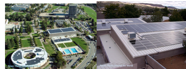
Figuras 6.2: Tejedados planos con paneles solares.
