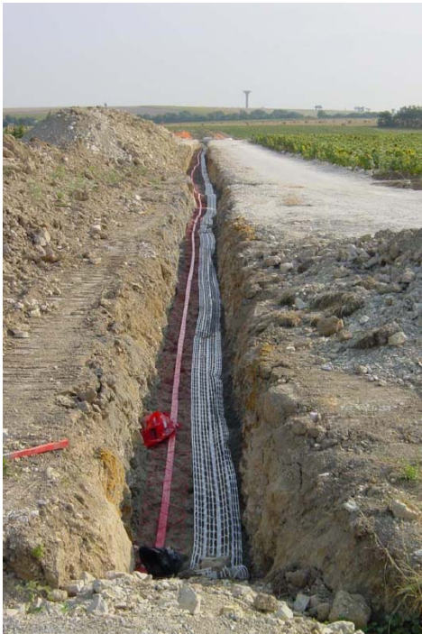
Fig. 7 : photo enfouissement du réseau électrique
