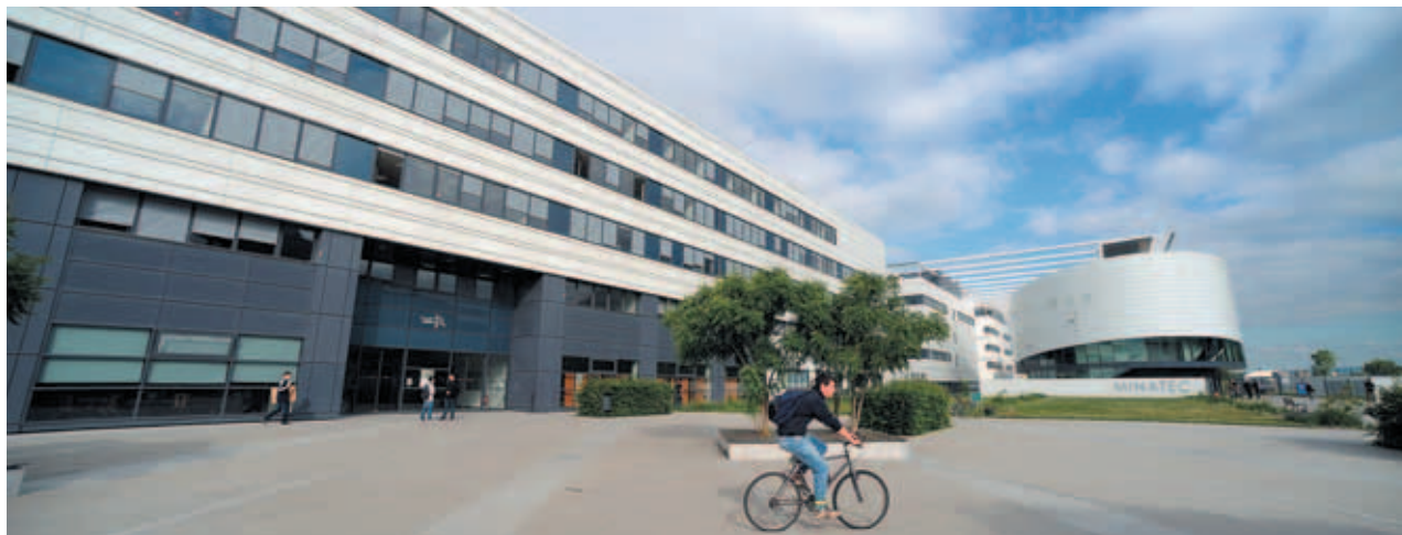
> Vue extérieure du bâtiment Minatéc à Grenoble.
