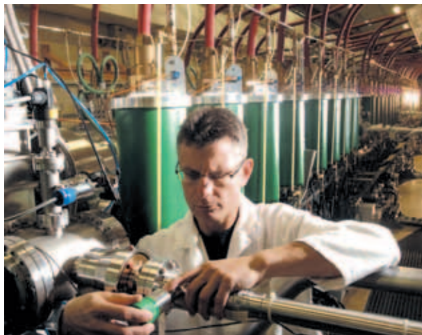
> Maintenance et réglage sur l'installation Airix.
